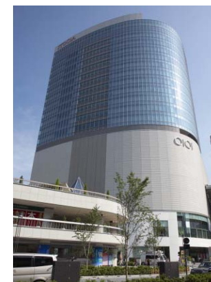
■日本プライムリアルティ ★ 有楽町駅前ビルディング (有楽町イトシア) 丸井を核店舗に、オフィスを兼ね備えた複合商業施設
